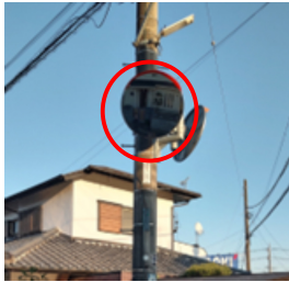
カーブミラー設置（大沼町）
