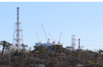
工事が進められている東海第2原発
