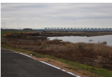
堤防整備と河道掘削が計画されている久慈川
