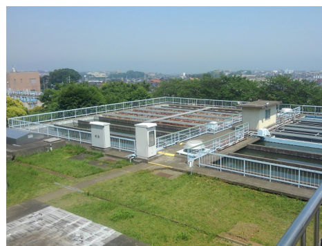
久慈川を水源とする森山浄水場
